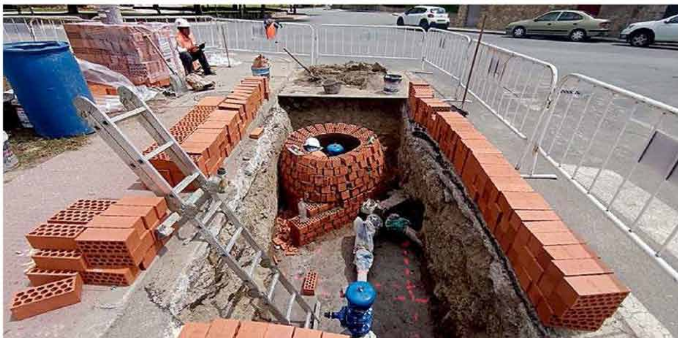
En los próximos cinco años realizará una gran aportación en obra hidráulica para atender las necesidades de una población en crecimiento.
