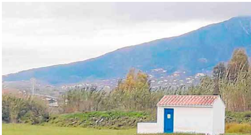
Vista del casetón que protege uno de los pozos de Guadalmanza. SUR
