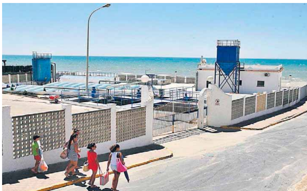
Varios veraneantes pasan junto a la depuradora de aguas residuales de Matalascañas, cuyo funcionamiento incumple la normativa y que será mejorado.
