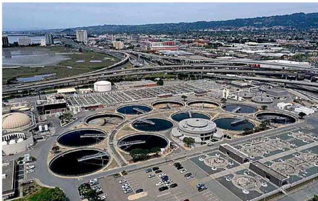
Planta de tratamiento de agua en California. Getty
