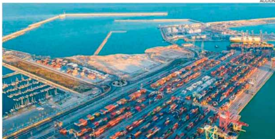
Obras de construcción de la terminal de contenedores para la ampliación del Puerto de Valencia
