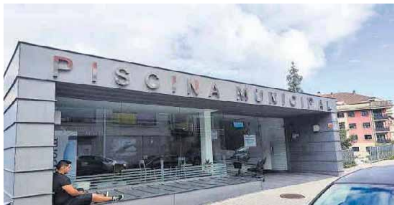
Fachada del edificio que alberga la piscina municipal de Moaña. | Santos Álvarez
