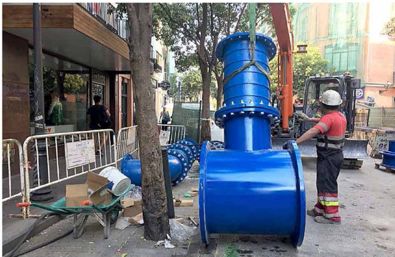
Las canalizaciones obsoletas se están reemplazando por otras fabricadas con materiales más avanzados.
